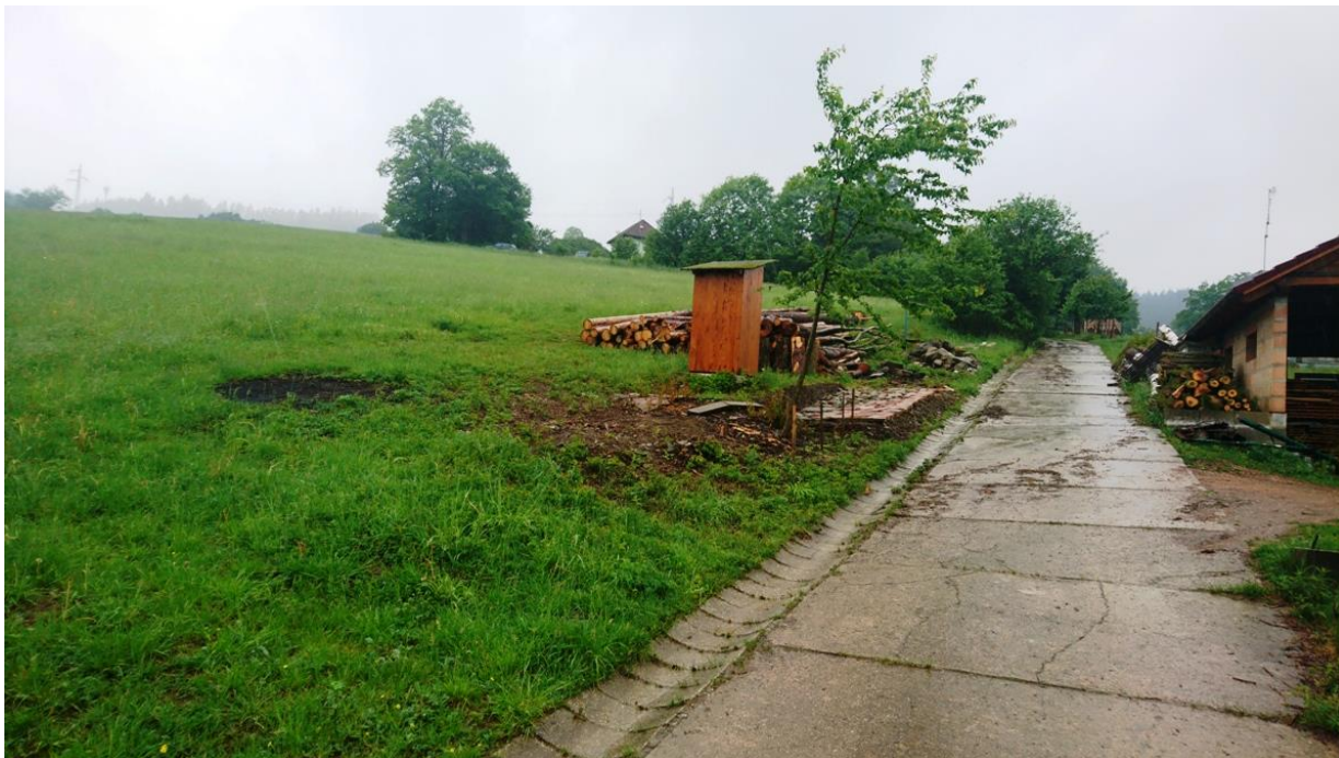
Přístupová komunikace k vodojemu
